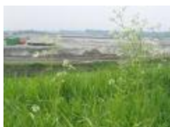
Graafwerken bij de ontpoldering (IMG_0819)
