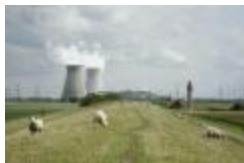
Dijk met zicht op de koeltorens van Doel (IMG_9293)
