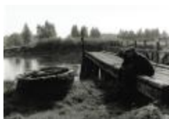
Zicht langs de Durme nabij Tielrode, 1951-2005 (77)
