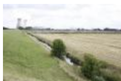
Polderzicht met koeltorens (_MG_0022)
