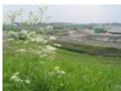
Graafwerken bij de ontpoldering (IMG_0821)
