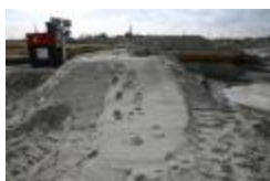
Opgespoten zand (IMG_9610)
