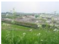
Graafwerken bij de ontpoldering (IMG_0820)
