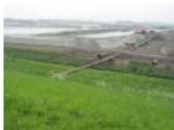
Graafwerken bij de ontpoldering en havenuitbreiding (IMG_0818)
