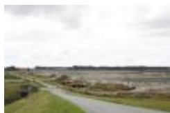
Zicht op de werken in de Prosperpolder (_MG_0014)
