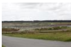
Zicht op de werken in de Prosperpolder (_MG_0015)
