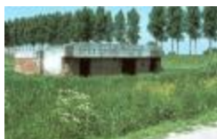
Bunker in de Fortstraat, Doel (PCPP20110912014)
