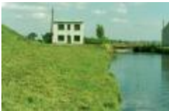
Huis aan de Witte Brug in Doel (PCPP20110912005)
