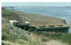
Verlaatsluis in Doel (PCPP20110912016)
