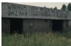
Bunker in de Fortstraat, Doel (PCJM20120902_005)
