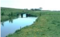
Watergang onder de scheldedijk (PCPP20110912006)
