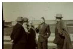
Bedrijfsbezoek aan waterzuiveringsstation (PCWVB20110415_011)
