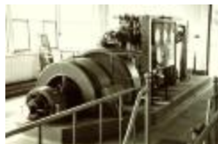
Bedrijfsbezoek aan waterzuiveringsstation (PCWVB20110415_012)
