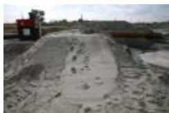
Opgespoten zand (IMG_9610)
