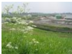
Graafwerken bij de ontpoldering (IMG_0821)
