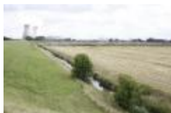
Polderzicht met koeltorens (_MG_0022)
