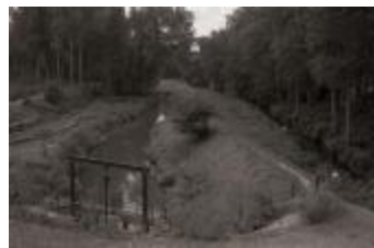
Heirbeek sluice 1990-2012 (Heirbeek sluice west voor)
